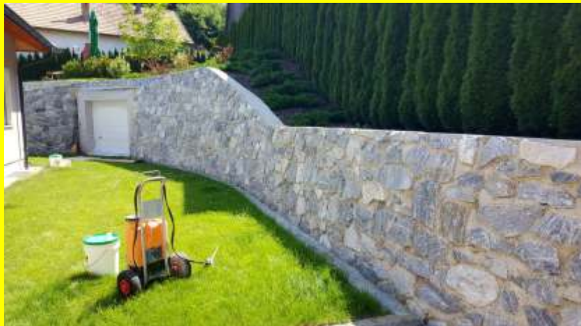
Granit-Stützmauer
